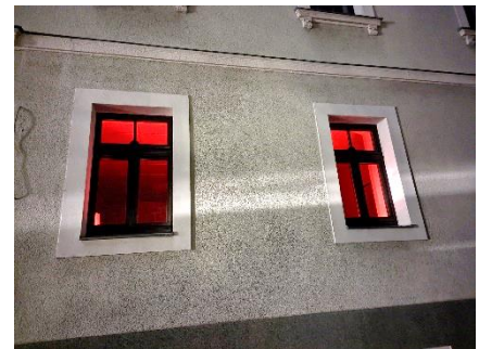
Beleuchtung IKS - Außen
